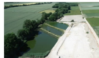
Assainissement > lire p20-23
