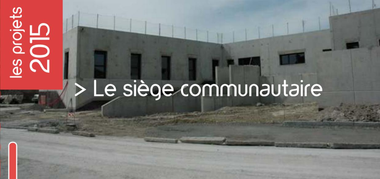
Les travaux de construction du siège communautaire lancés en juillet 2014 avancent rapidement. Les travaux de gros œuvre sont terminés. Le bâtiment est aujourd'hui clos et couvert. Les entreprises ont engagé les travaux de second œuvre à l'intérieur du bâtiment. Plaquistes, électriciens, plombiers, chauffagistes, peintres sont à l'œuvre.
