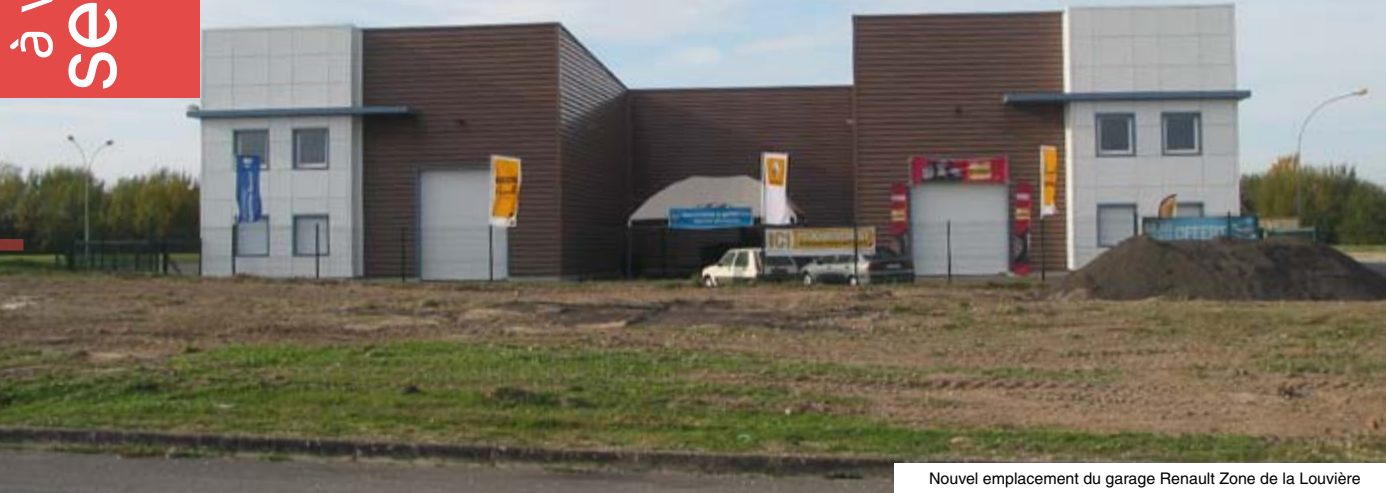
Nouvel emplacement du garage Renault Zone de la Louvière
