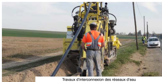
Travaux d'interconnexion des réseaux d'eau
