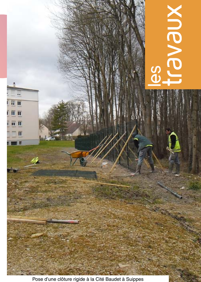
Pose d'une clôture rigide à la Cité Baudet à Suippes
