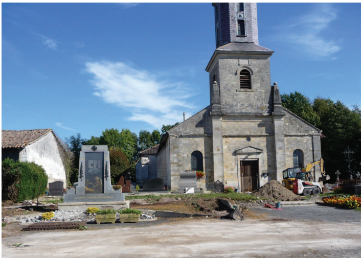
Pendant les travaux
