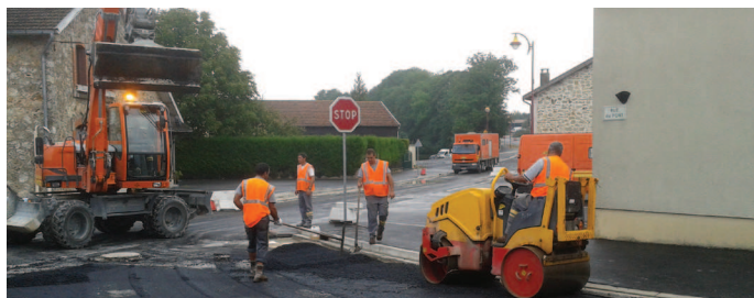
Travaux de voirie à Somme-Tourbe
