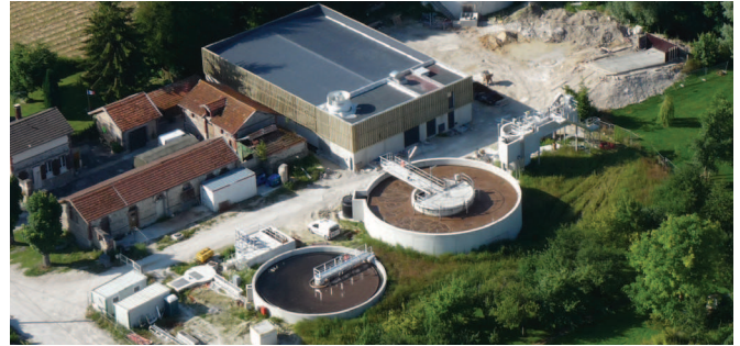
La STEP en travaux
