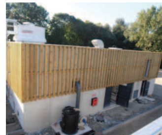
L'aire de stockage des boues et les locaux techniques
