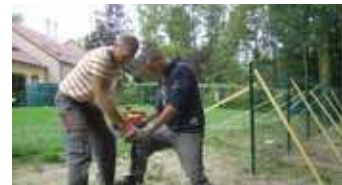
■ Pose d'une clôture à Suippes
