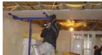
■ Travaux d'intérieur dans une maison communale à Suippes
