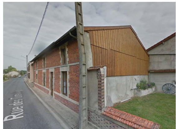
Bussy-le-Château Exemple sur un bâti ancien
