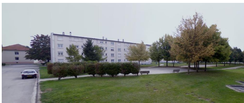
Logement collectif à Suippes
